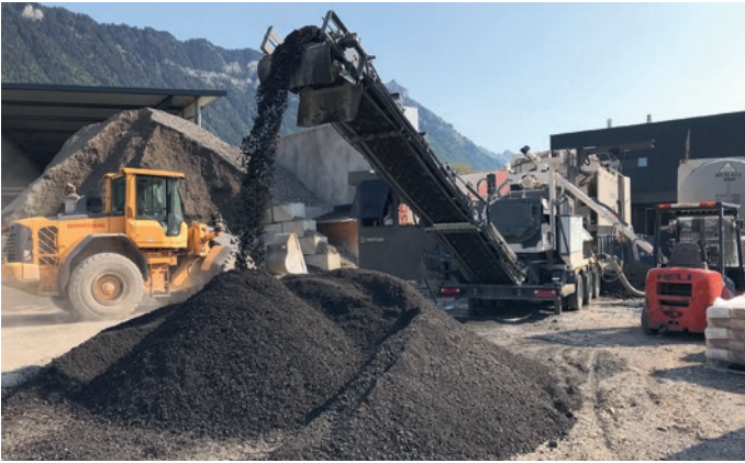
Produktion von BSM Material mit einer Wirtgen Kaltmischanlage KMA 220i.
