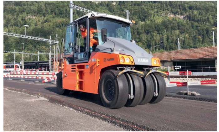
Verdichtung von BSM Material.
